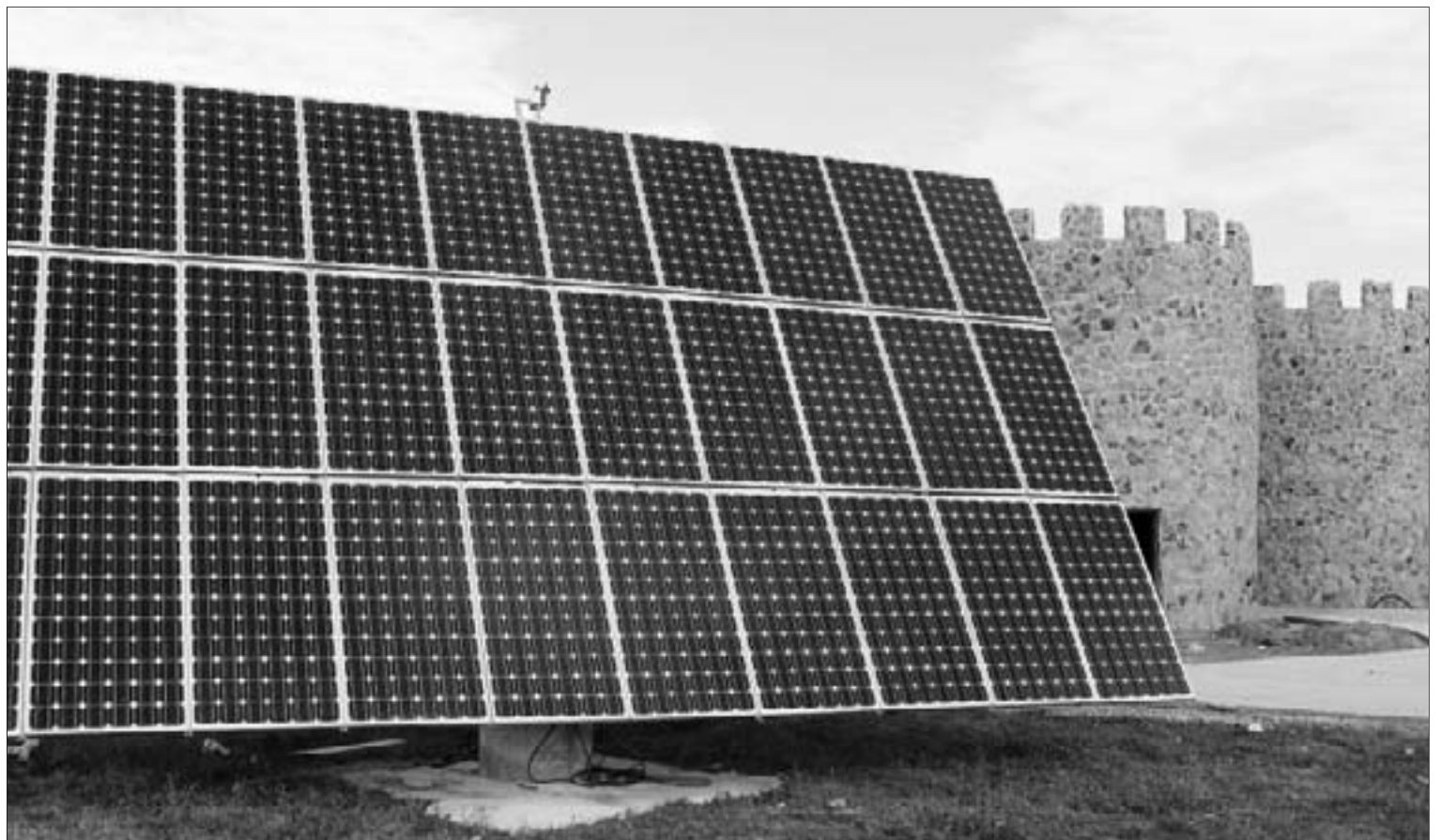
El seguidor solar, una gran placa capaz de orientarse por sí sola en dirección al sol y uno de los suministradores de energía más importantes de este campo.
